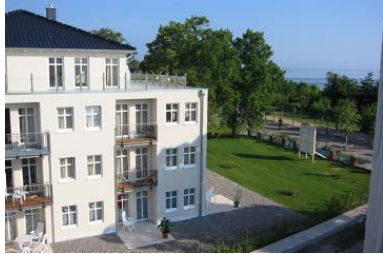
Hausansicht "Villa Aquamarina" von der Südseite
