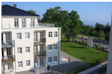
Hausansicht "Villa Aquamarina" von der Südseite
