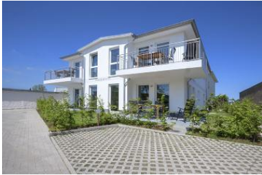
Hausansicht Neubau Villa Margarete
