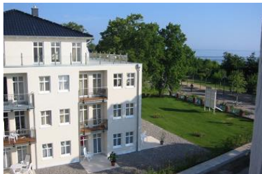
Hausansicht "Villa Aquamarina" von der Südseite (Nachbarhaus)
