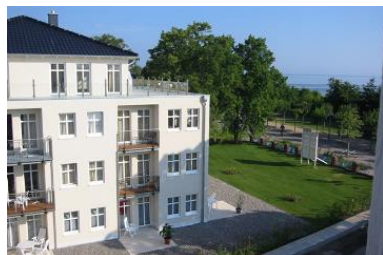
Hausansicht "Villa Aquamarina" von der Südseite
